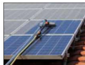
Zonnepaneel reiniging
